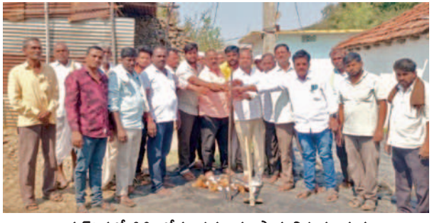
దామరగిడ్డలో సిసి రోడ్డు పనులను ప్రారంభిస్తున్న దృశ్యం
